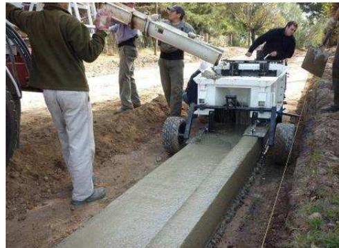
Elimina los clásicos moldes metálicos. Solo basta con nivelar el terreno, ponerle el hilo-guía en nivel, y listo!!!!
